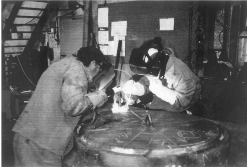
Abbildung 17: In-Situ - Messung der Abkühlungszeit, Seebrücke Heringsdorf
